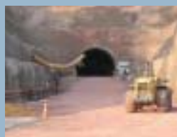
Under construction. © FIVAS and Proyecto Gato.
